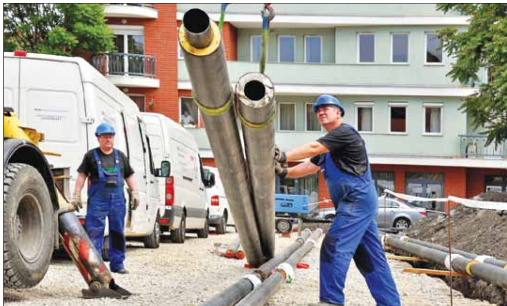
Összekötő vezeték építése a Patak utcában
