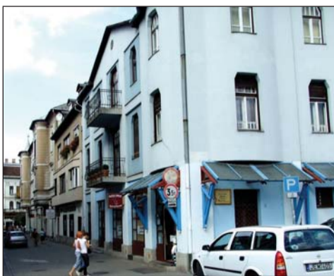
Az épület délnyugati homlokzata.
