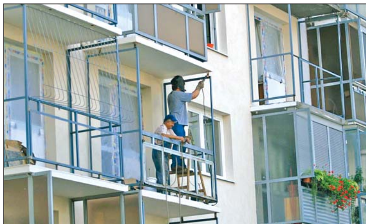
A városban jelenleg is több épület újul meg a programban.
