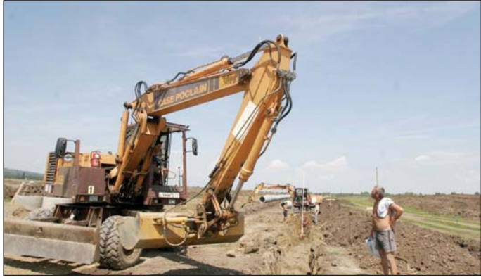
Az épülő ipari park.
