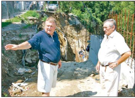
Augusztus végére készülhet el a vasbeton támfal.
