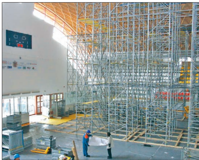
Állványrendszerrel végzik a tetőszerkezet ellenőrzését.
