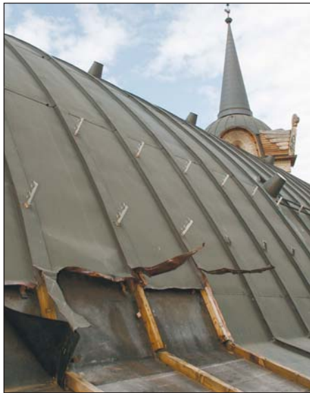
A belső burkolatot felszakították, az ereszcatornáknak húlt helye.
