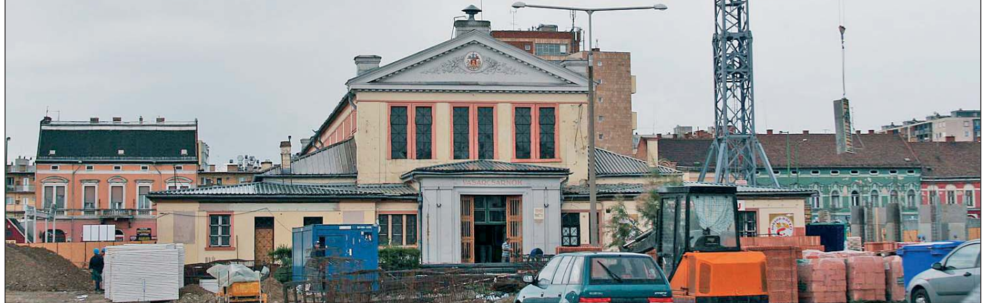
Jelenleg a Vásárcsarnok két új épületszárnya készül.
