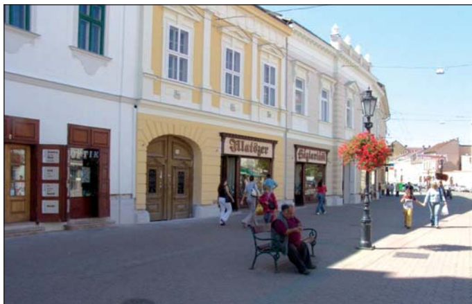
A közelmúltban megújult belvárosi épületek.
