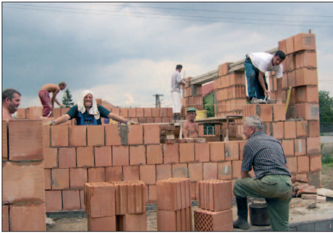
Gyűjtene és saját maguk építkeznek a gesztelyiek.
