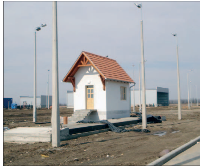
Épü a Hejőpapiban készülő hulladéklerakó.
